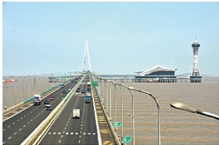
杭州湾跨海大桥
