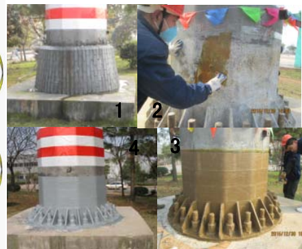
图4: 复层包覆施工流程及整体效果
